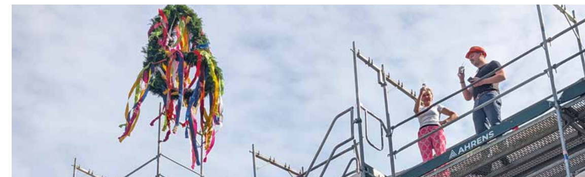
Die Richtkrone ist gesetzt: Ein neues Kinder- und Familienzentrum entsteht in Gröpelingen (s. S. 27).
